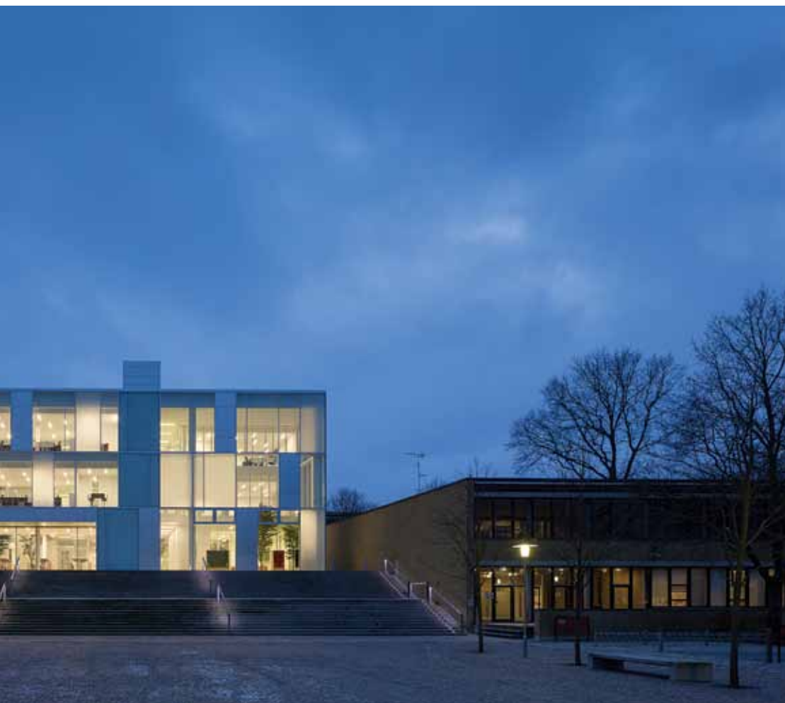
DTU Compute's nye bygning (324) på DTU's Lyngby Campus. Foto: Adam Mørk
